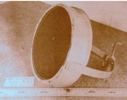
*Nachtfahrgerät infra-red filter for the headlights.*
